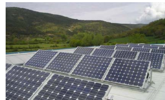
Foto 2: Instalación inclinada
